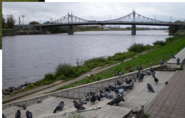
Die große Wolga-Brücke in Twer (= Kalinin in der Sowjet-Ära). Vom Quellgebiet bis Twer hat die Wolga rd. 320 km zurückgelegt; die Flußbreite ist hier schon sehr beachtlich.
